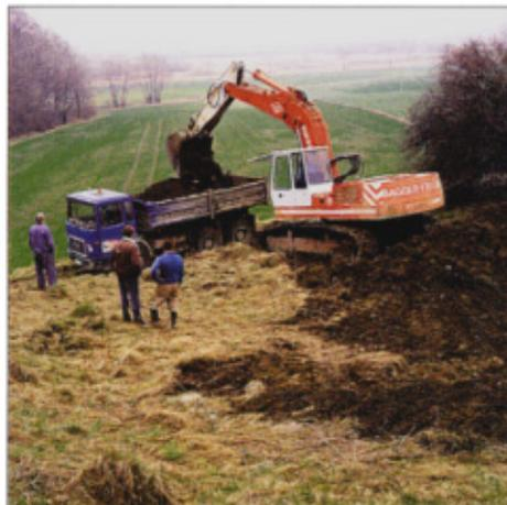
*Der aufgeschüttete Fremdboden wird wieder entfernt.*
