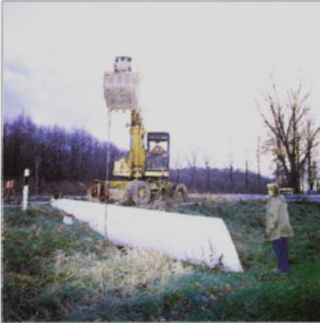
Das Straßenbauamt verlegte einen Froschtunnel und baute im Grabenverlauf mit einfachen Mitteln (Doppelleitplanken) einen Froschzaun.
