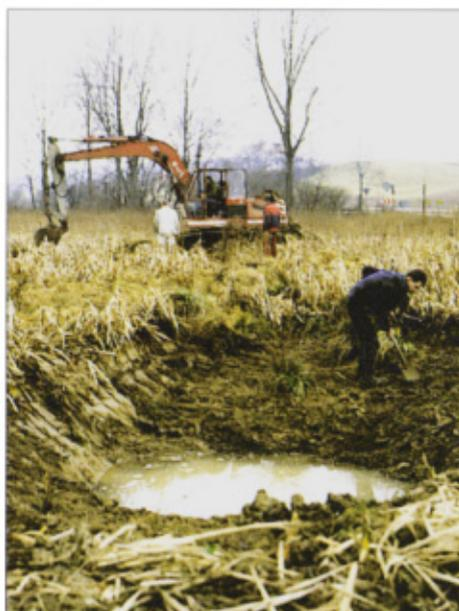
*Vom Mutterboden des geplanten Fahrradweges und dem Aushub der drei kleinen Tümpel (Bild rechts) haben wir zur Vernässung des Grundstücks eine Verwallung aufgebaut.*
