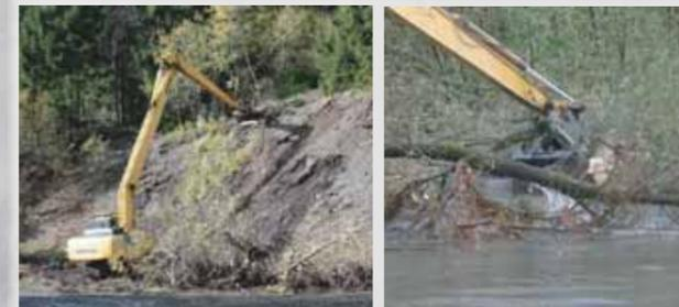
Siebzehn Meter Ausleger ermöglichten es dem "Monsterbagger", beim Freilegen der Schieferhalden und den anschließenden Arbeiten, das Befahren der empfindlichen Bodenbereiche zu vermeiden. Die letzte Großmaschine im Einsatz war der Schredder, der die Reste beseitigte. Zwei Landwirte aus Heißum standen mit ihren Traktoren dort zur Verfügung, wo selbst die Rückepferde es nicht mehr schafften.
